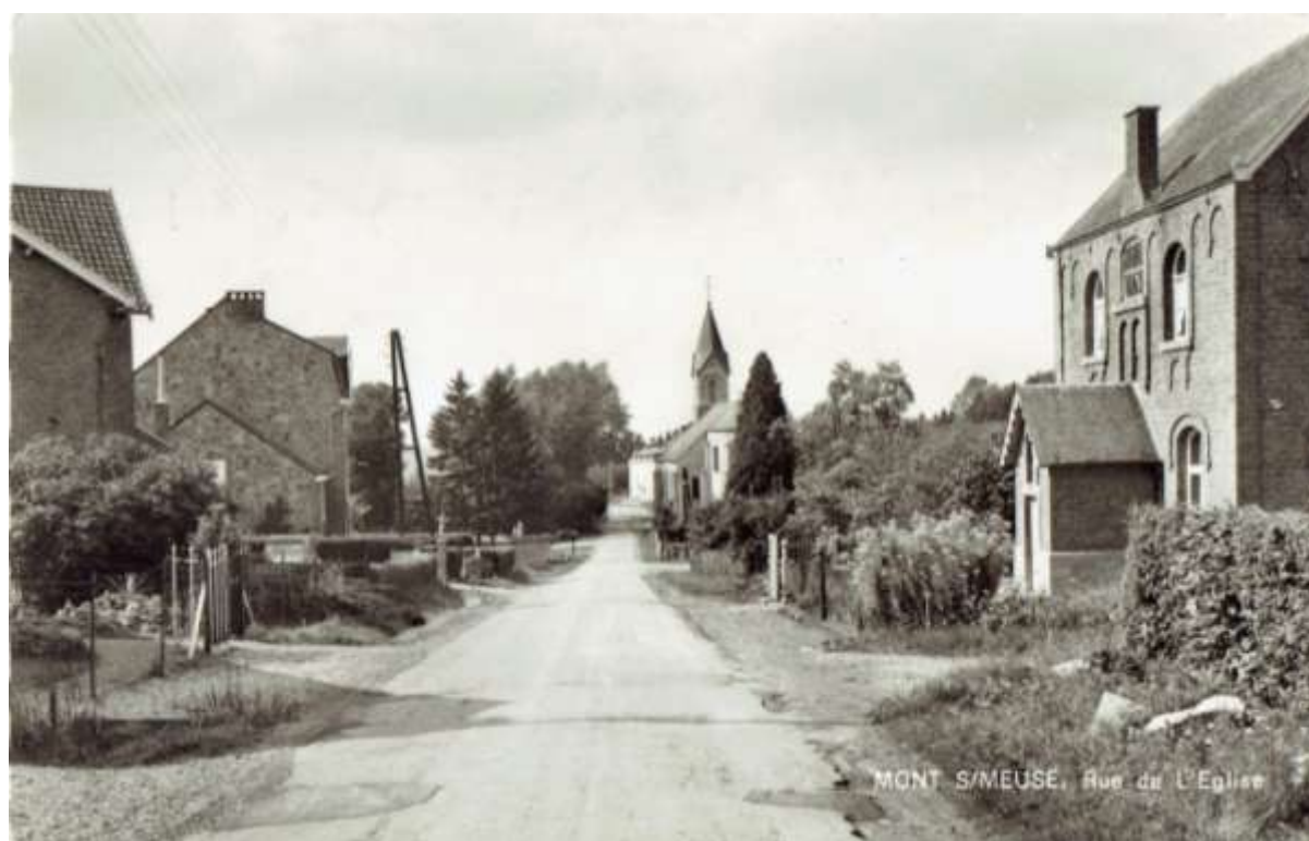
Figure 177. Mont-sur-Meuse – l'église avant transformations. © bibliotheca.yvoir.be
